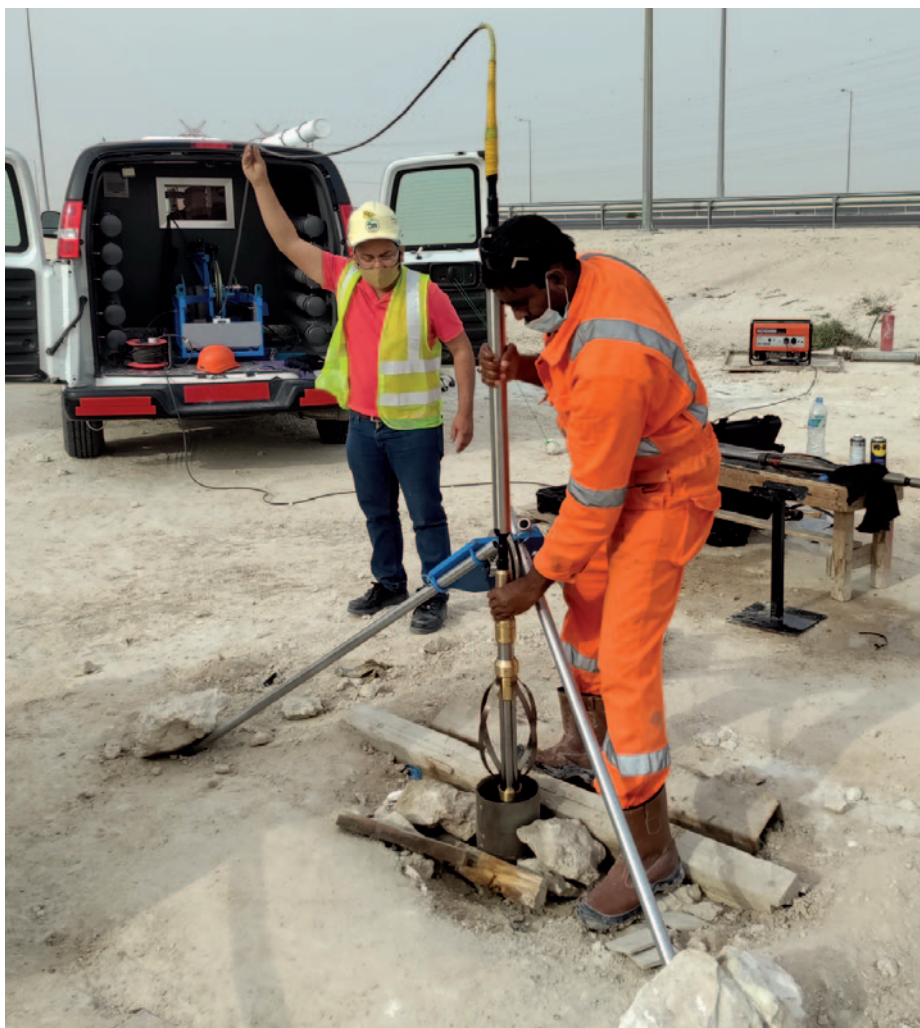
Скважинная камера RGeo-eye® с утяжеленной штангой применялась в геотехнической скважине.
